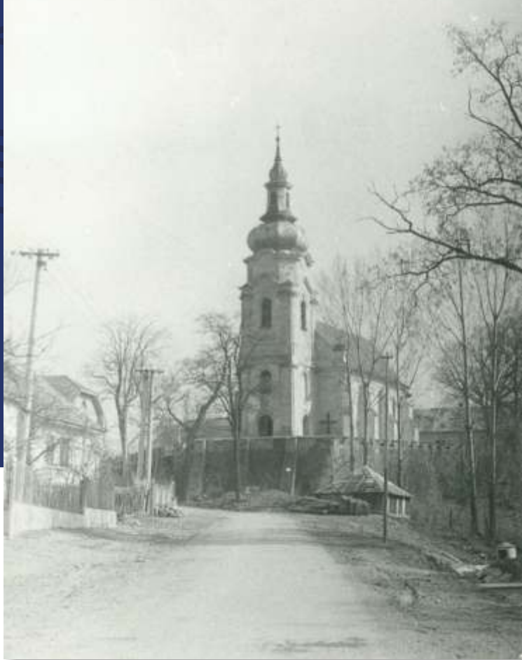
Pohľad na kostol z dnešnej ulice Matúša Čáka Trenčianskeho. Stav pre rekonštrukciu v 70. rokoch. Zdroj: p. Nagyová.
